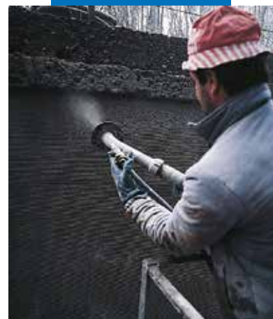
Канал гидроэлектростанции Бертини – Роббьяте (Комо) – Италия: нанесение напылением
