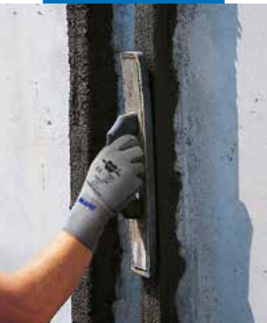
Отделка при помощи гладилки
