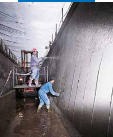
Канал гидроэлектростанции Бертини – Робьяте (Комо) – Италия: отделка мастерком
